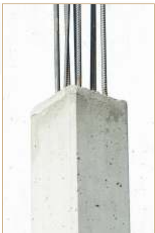
Каркас - монолитный железобетонный
